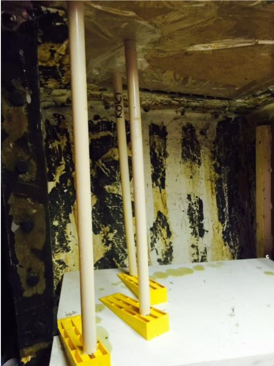
Figur 7 Hyllplan sattes upp för att sätta spjörn mot oljeboarden
