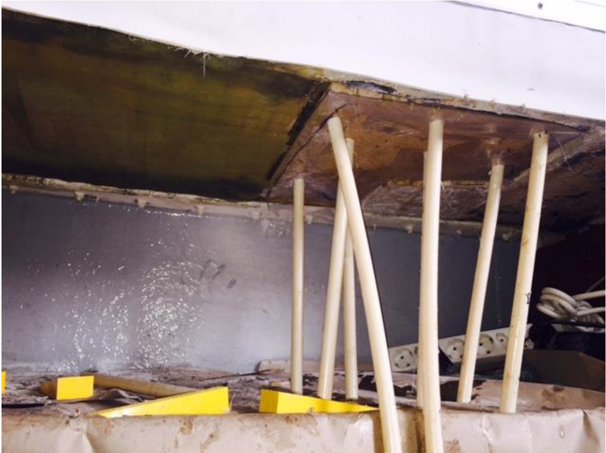
Figur 6 Lagom stora bitar plastades åt gången, för stora bitar blev väldigt otympligt
