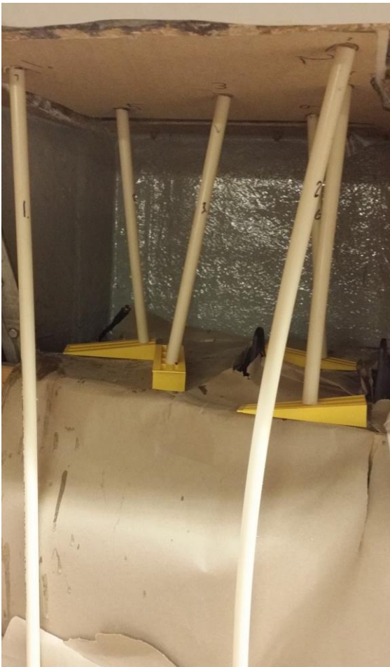
Figur 5 Pressar upp innertaket under härdning
